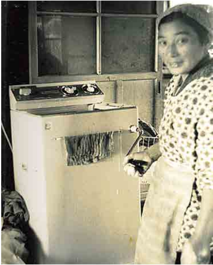
▲三種の神器「電気洗濯機」(郷土出版社「石巻・東松島・女川今昔写真帖」より・昭和30年代) テレビ・電気掃除機とともに主婦の家事労働を助ける三種の神器として広まった。当時の性能は今と比べものにならないほど低く、脱水機能は、ゴムローラーの間に洗濯物をはさみ、手動ハンドルで回すというものだった。
