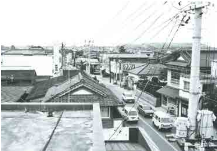
▲蛇田支所西側周辺(昭和56年撮影・「グラビア石巻」より)
