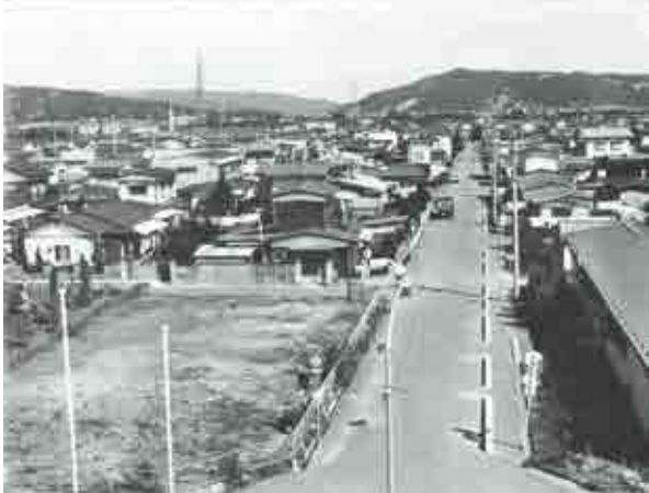
▲向陽小学校屋上からの俯瞰(昭和56年・「グラビア石巻」より)
