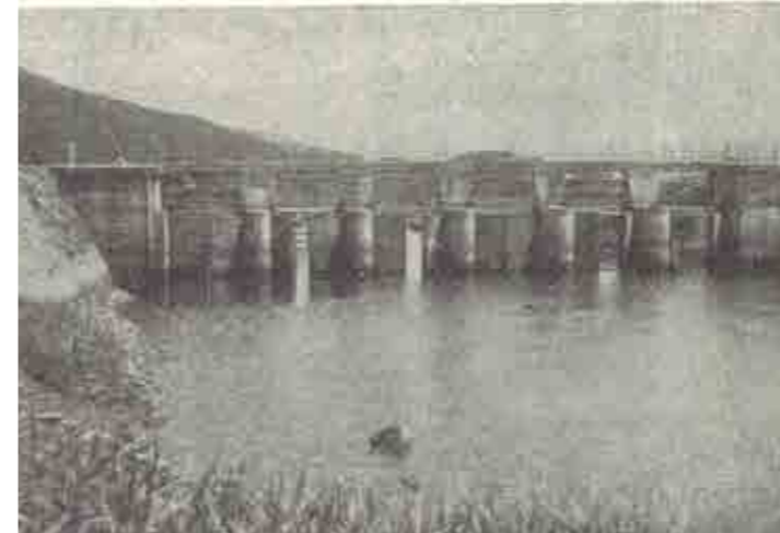
▲ 真野川の閘門(昭和30年代・「稲井町史」) 古来より、地勢的宿命であった真野川の治水対策は、昭和26年に全額国庫事業として起工した。堤防改修で対応できない北上川の逆流対策として閘門を設置し、昭和27年真野川閘門が竣工した。
