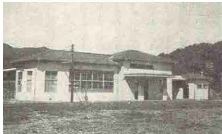
▲ 開業当時の陸前稲井駅(昭和14年頃・「稲井町史」) 昭和14年、女川まで延伸した石巻線には、石巻～女川間に陸前稲井、渡波、沢田の3駅が設置された。駅舎が渡波や女川と類似しているのは、大正末期から全国に鉄道網がひろがり、主要駅以外は基本となる設計図を流用したためと考えられる。
