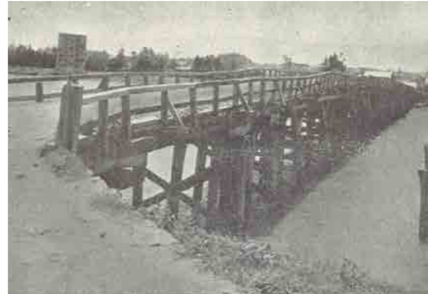
▲ 開北橋 昭和23年架橋の開北橋は、石巻と稲井西部及び旧河北町方面を結ぶ橋で利用者が増大していたが、橋自体が狭小で脆弱な木造橋のため、増水時の危険性もあった。写真左は昭和30年代前半の大瓜方面から水押側を(「稲井町史」)、右は昭和39年、水押側から大瓜方面を見る写真(「今昔写真帖」)で、上流側の杭は増水時の流木や冬季の水等への備えという。写真の通り、車両は通行できず、徒歩と軽二輪のみの通行だった。橋を渡る途中に何箇所かの穴があり、そこから北上川の水面が見え、怖かったという人も多い。
