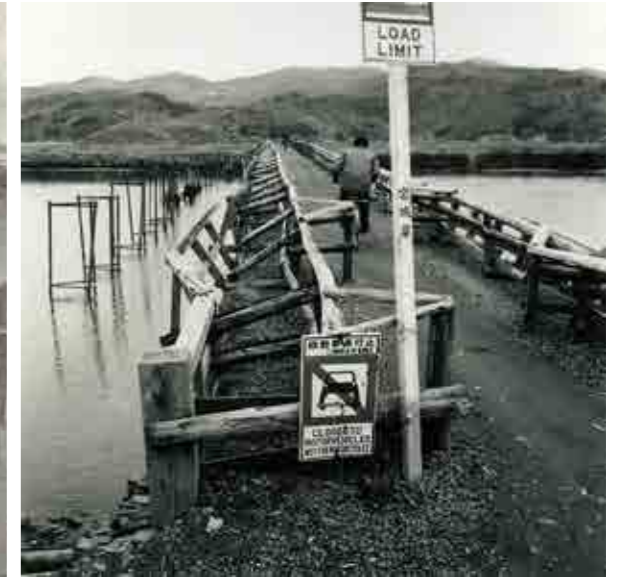
▲ 開北橋 昭和23年架橋の開北橋は、石巻と稲井西部及び旧河北町方面を結ぶ橋で利用者が増大していたが、橋自体が狭小で脆弱な木造橋のため、増水時の危険性もあった。写真左は昭和30年代前半の大瓜方面から水押側を(「稲井町史」)、右は昭和39年、水押側から大瓜方面を見る写真(「今昔写真帖」)で、上流側の杭は増水時の流木や冬季の水等への備えという。写真の通り、車両は通行できず、徒歩と軽二輪のみの通行だった。橋を渡る途中に何箇所かの穴があり、そこから北上川の水面が見え、怖かったという人も多い。
