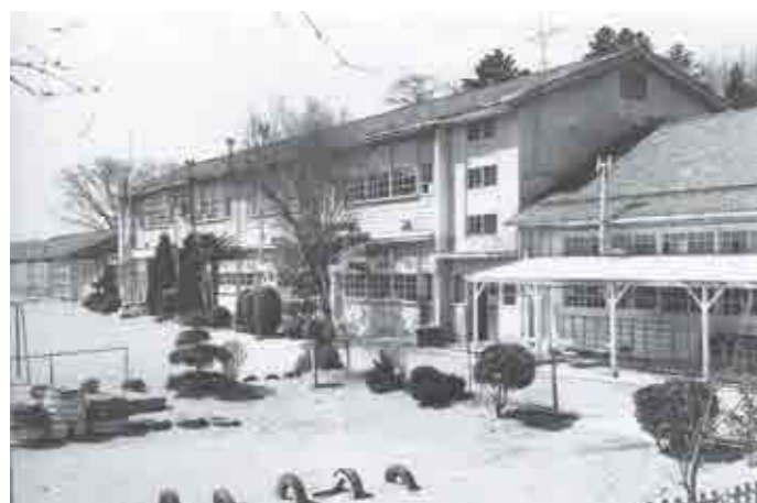
▲ 真野小学校(昭和50年頃・亀山幸一著「グラビア石巻 第3集」) 明治6年真野小学校として長谷寺に開校。同22年、稲井尋常小学校真野分教場となるが、同34年真野尋常小学校として独立。その後、稲井村立、稲井町立、石巻市立を経て、昭和56年3月稲井小に統合し、閉校。
